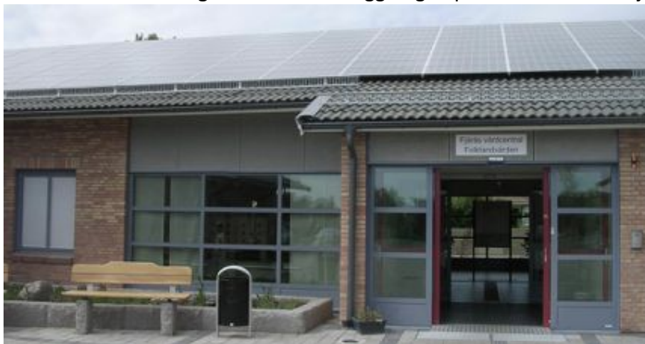
Figur 2, 13 år gammal solcellsanläggning på vårdcentralen i Fjärås.
